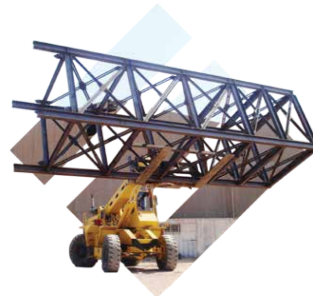
Estructura ampliación / Planta Codelco Chuquicamata
